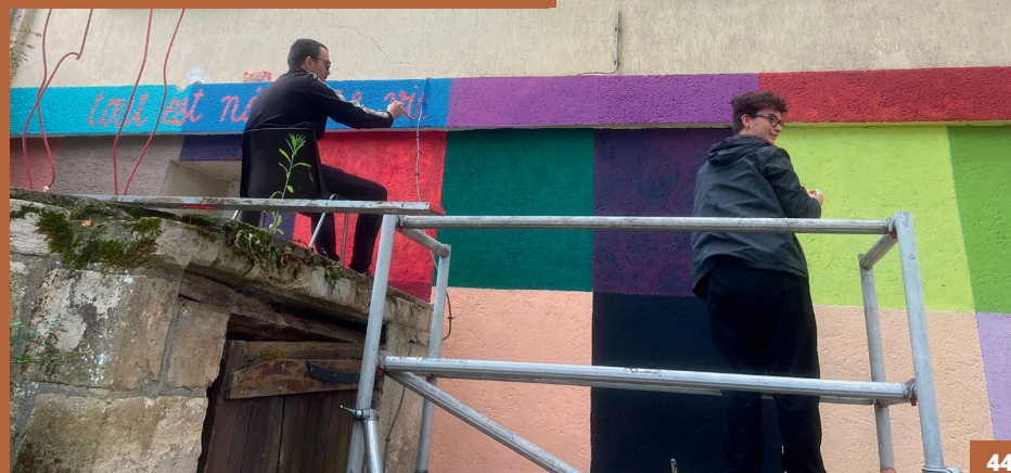
Construction d'une allée en pavés et réalisation de la fresque murale avec les jeunes participant au chantier
