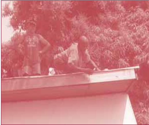
Travaux en 2009 sur le toit de la Salle des Savoirs
