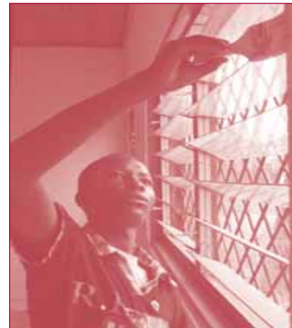
Devant nous.....du chantier !
